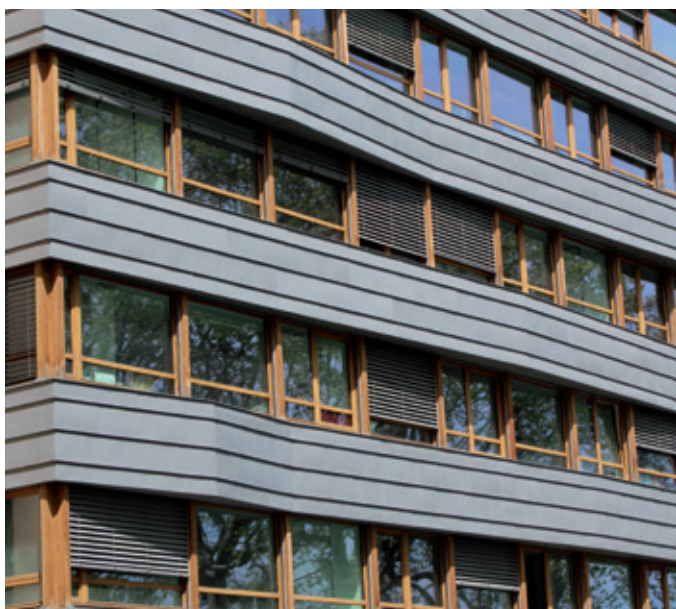
Bureaux à Lyon FOB sur structure béton existante Vêtture métal avec des nus extérieurs variables I.Raveau, Architecte
