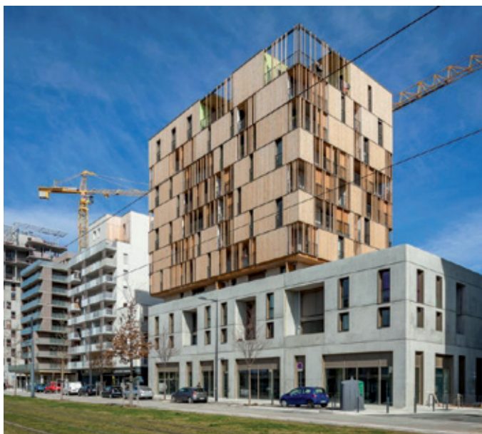
Logements bois à Grenoble FOB sur structure béton Roda Architecte
