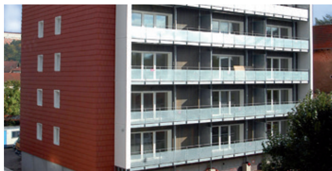
Logements bois paille à Saint-Dié Vêtture terre cuite ASP architectes
