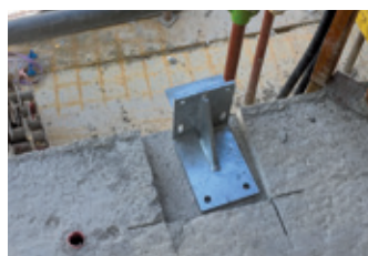
Réservation réalisée après coulage dans des conditions de sécurité délicates
