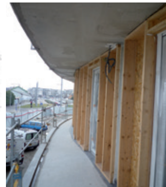
Les ponts thermiques au niveau des planchers doivent être gérés, ainsi que les jeux de pose en partie haute
