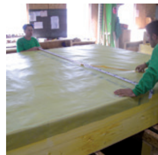
Mise en œuvre des composants d'étanchéité en atelier
