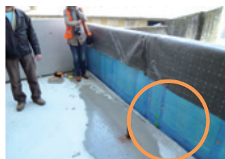
Mise en œuvre sans protection des FOB en cas d'orage
