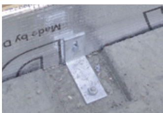
Réservation réalisée avant coulage
