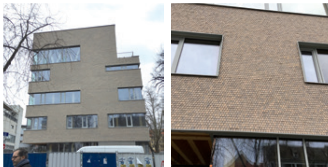
Maison des Personnels de l'Université de Strasbourg, Bardage bardeaux de bois AJEANCE Architecte
