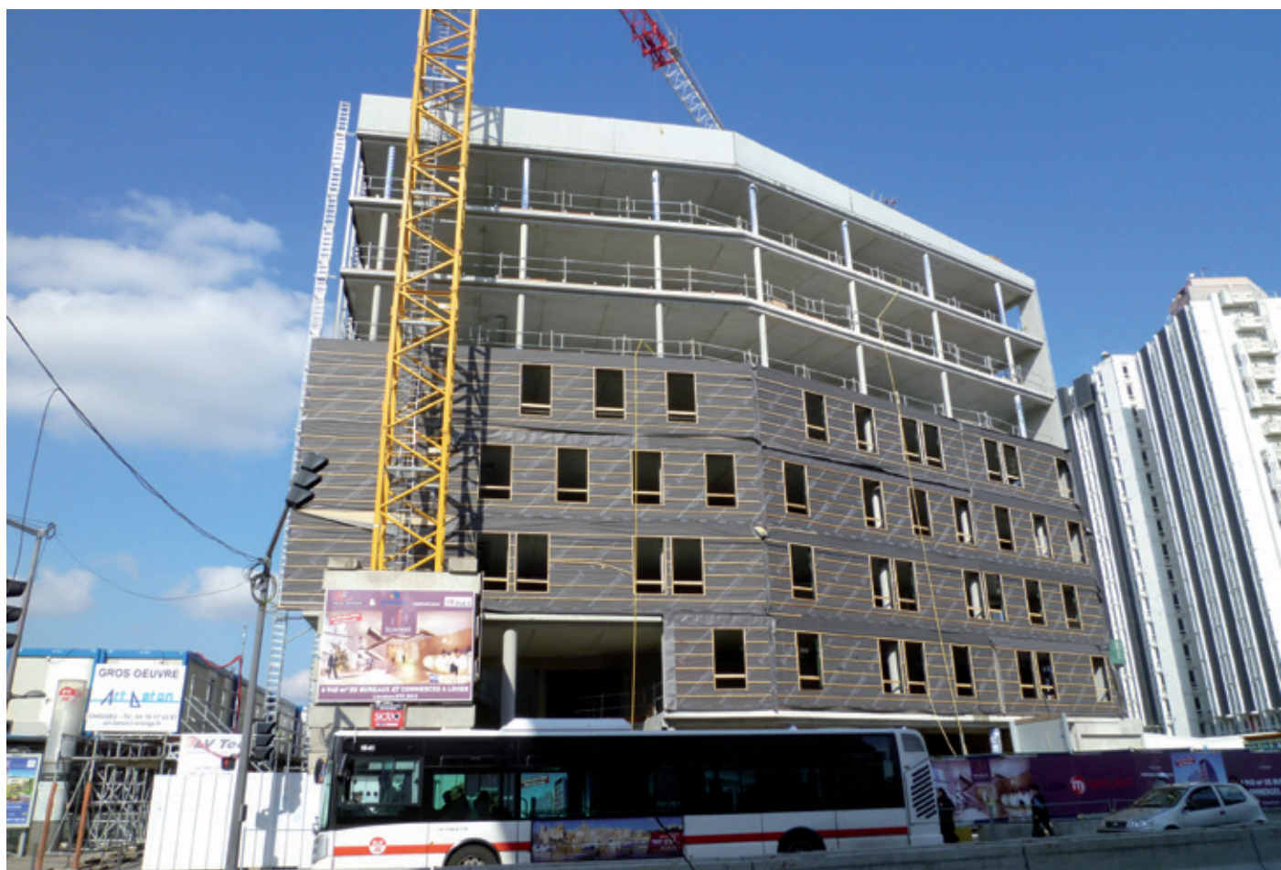
Bureaux à Lyon FOB sur structure béton, parement métallique Hervé Vincent architecte
