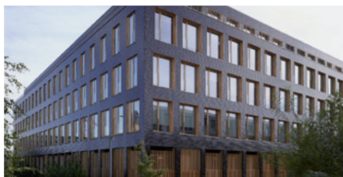
Bureaux TERRENO à Strasbourg Vêtture terre cuite vernissée Béal et Blanckaert architectes
