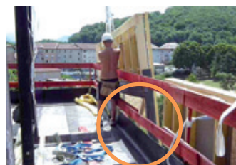
Mise en œuvre d'une solution pour protéger les FOB
