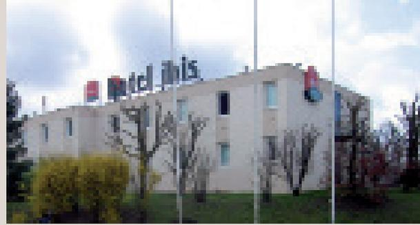
Structure : refends porteurs et façades en voile de 14 cm et planchers de 16 cm en béton armé. Isolation intérieure de 10 cm. Trame entre chambre de 2,70 m. Toiture terrasse avec étanchéité bitumée et gravillons. Menuiseries PVC en bon état, changées 5 ans auparavant.
