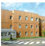
Intervention : pose de panneaux ossature bois verticaux avec isolant, OSB et bardage bois.
