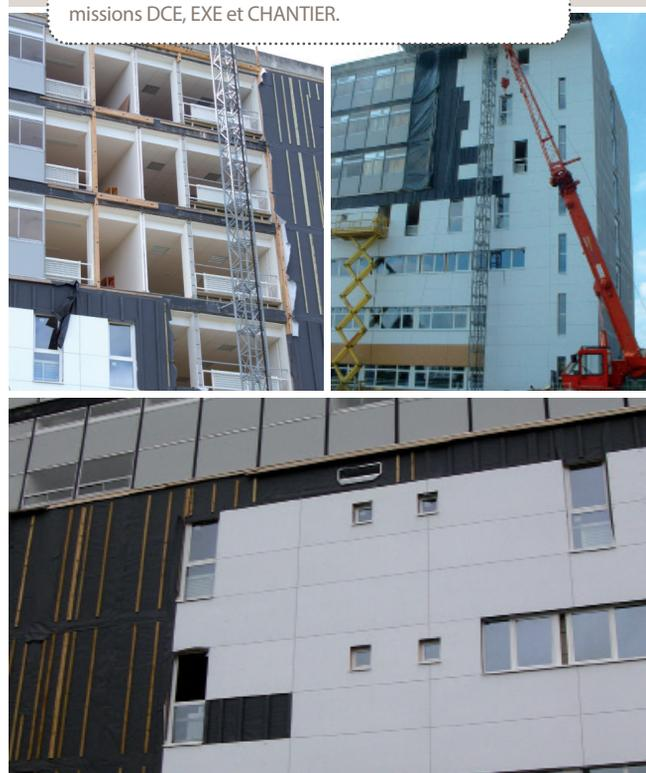
Le calepinage de la vèture ne correspondant pas aux dimensions des panneaux bois, les panneaux fibre-ciment sont posés in situ.
