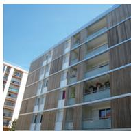
Intervention : pose ossature bois, isolant et bardage bois in situ.
