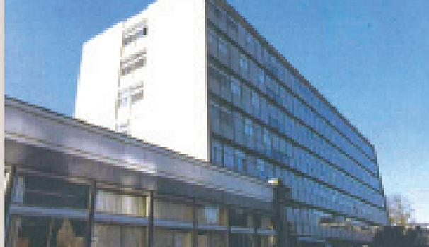
Diagnostics réalisés : aucun désordre particulier observé sur la structure. La qualité de finition des bétons en façade est médiocre. Présence d'amiante dans les panneaux d'allège des façades.
