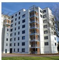
Intervention : pose de panneaux ossature bois horizontaux avec isolant, pare-vapeur, parement intérieur et bardage fibre-ciment.
