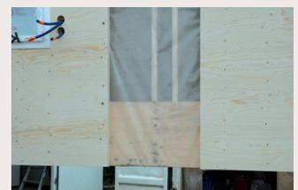
Parement lamibois côté intérieur. Réservation pour le passage d'un poteau qui laisse devenir la poutre porteuse en lamibois horizontale, assurant également la liaison entre les deux parties d'ossature et le pare-vapeur.
