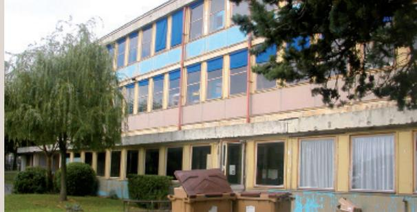
Structure : poteaux, poutres, planchers et refends porteurs en béton armé. Façades composées de panneaux menuisés avec châssis bois simple vitrage et allèges en panneaux amiante-ciment. Toiture en bac acier simple peau sur charpente bois, avec une isolation en laine de roche de 10 cm.
