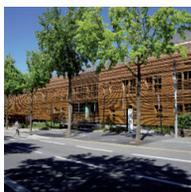
Intervention : réalisation d'une façade cintrée en 2 parties, l'espace dans la partie concave sert au passage des réseaux ①. Pose de panneaux ossature bois avec isolant et pare-vapeur. Le bardage bois par éléments préfabriqués est posé in situ.
