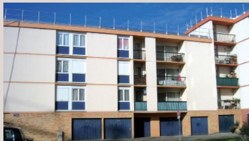
Structure : planchers et refends porteurs en béton armé. Façades en voile béton de 26 cm, sans isolation, recevant un traitement d'imperméabilité avec entoilage. En RDC, habillage en brique. Menuiseries extérieures PVC double vitrage avec allèges menuisées bois et panneaux amiante-ciment pour chambre et cuisine. Portes-fenêtres bois simple vitrage pour séjour. Toiture terrasse non accessible.
