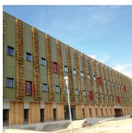
Intervention : pose de panneaux ossature bois verticaux ① avec isolant, pare-vapeur et Fermacell. Panneaux composites et végétalisation posés in situ.
