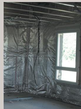
Dans l'opération du Cheylas (Ex 3) le mur ossature bois a une épaisseur de 145 mm, un pare-vapeur assure le blocage vapeur et l'étanchéité à l'air, puis une couche d'isolant de 70 mm en contre isolation vient compléter la paroi.
