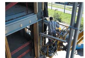
**1** Des réservations ponctuelles dans les panneaux ossature bois permettent de fixer les platines métalliques. **2 & 3** Une première équipe réalise la continuité thermique, avec l'isolant minéral et un panneau fibre de bois. **4** Une seconde équipe réalise la continuité du pare-pluie.
