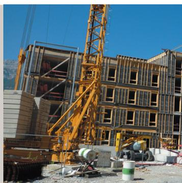
Lisse de calage avant le levage côté extérieur, puis après levage côté intérieur.
