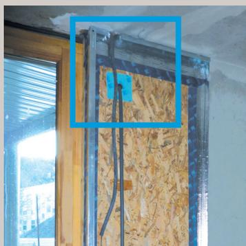
Les panneaux ouverts avec l'OSB à l'intérieur prennent le risque de recevoir les intempéries et de s'humidifier avant leur fermeture. En région humide, il est préférable d'utiliser un panneau fermé, équipé du pare-pluie extérieur.
