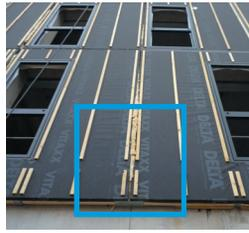
Bourrage de l'isolant entre panneaux.
