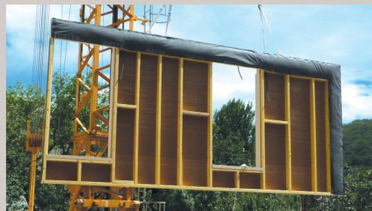
La laine minérale destinée à l'étanchéité aux gaz, (IT249) est encapsulée dans un film, sur le panneau et sera comprimée à la pose.
