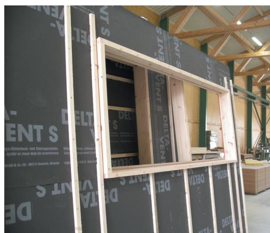
Le pré-cadre bois est réalisé par le charpentier et intégré dans le corps du mur. Dans ce cas, la pose de la menuiserie n'interfère pas avec le lot bardage.
