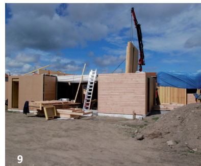
8_Pose de l'enduit à la chaux sur les parois intérieures afin d'améliorer le confort d'été. 9_Levage des murs.
