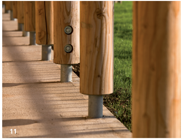
11_Détail en pied des poteaux ronds fraisés réalisés en Douglas et porteurs des coursives.
