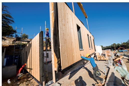
4_Vue des bâtiments 1 et 2 et leurs panneaux photovoltaïques depuis les coursives du bâtiment 3. 5_Accès extérieur du bâtiment 3. 6_Mise en place des murs préfabriqués.
