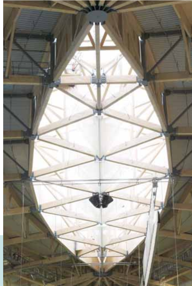
▲ Une verrière à ossature bois éclaire le stade tout en participant à la statique de l'ensemble.
