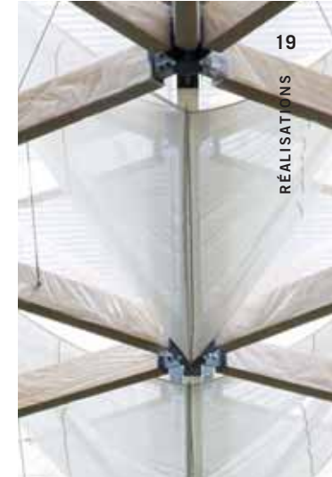
▲ Une verrière à ossature bois éclaire le stade tout en participant à la statique de l'ensemble.
