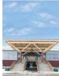
◀ La forme régulière du complexe sportif n'est interrompue que par la présence d'un auvent géant à structure bois qui protège les escaliers conduisant aux tribunes.
