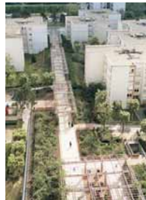
◀ La pergola en mélèze brut non traité structure l'espace entre les immeubles et devient le principal repère d'orientation du quartier.
