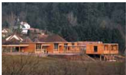
▲ Installée dans la pente, l'école se tourne vers la vallée.
