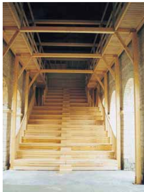
▲ Les arcades de pierres rythment l'emplacement des portiques qui composent la structure en bois.
