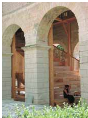
▲ Les arcades de pierres rythment l'emplacement des portiques qui composent la structure en bois.
