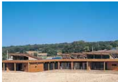
▲ L'orientation au sud des façades cadre des vues sur le massif du Lubéron et dispense la lumière en abondance.
