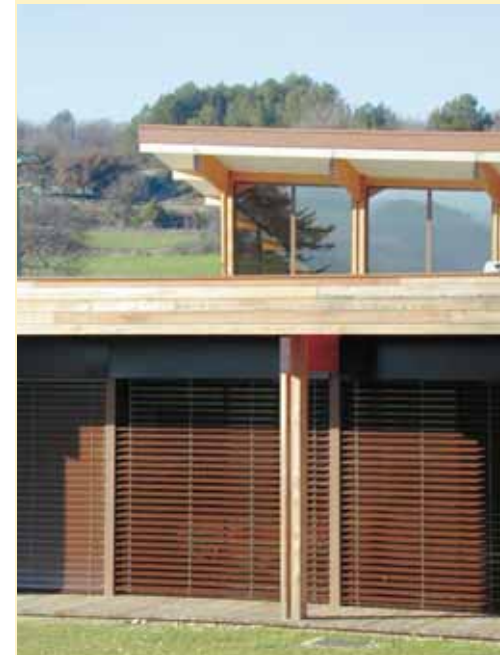
▼ Auvents et stores mobiles constituent les protections solaires de la façade sud.
