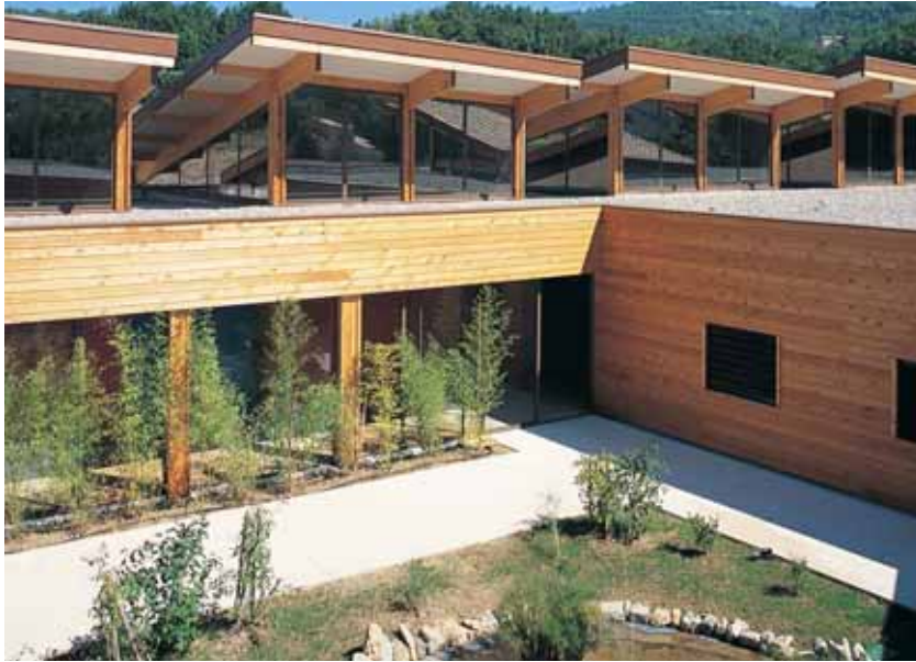
▲ Des volumes à structures bois émergent du toit-terrasse et dispensent en profondeur la lumière naturelle.
