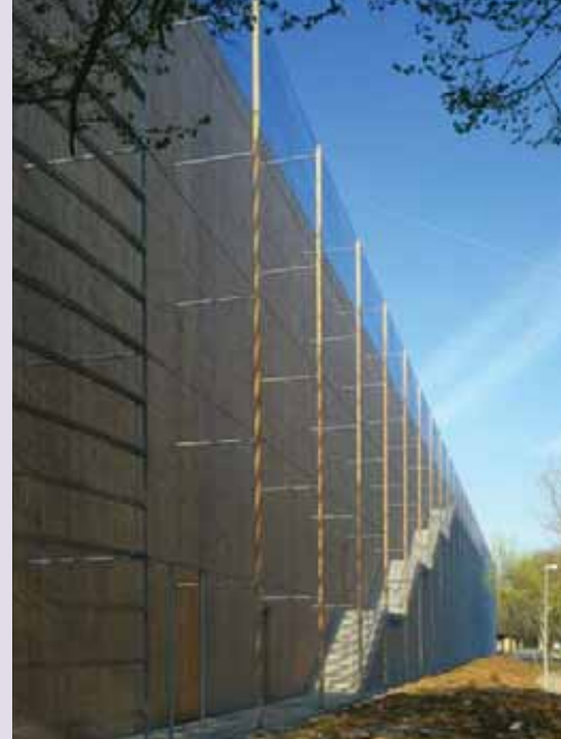
● Aux extrémités, des lames verticales de Douglas suivent la courbe des rampes d'accès.
