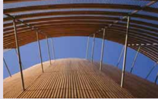
▲ ▼ Fixé sur des poteaux ronds, un grillage métallique double la façade en Douglas.
